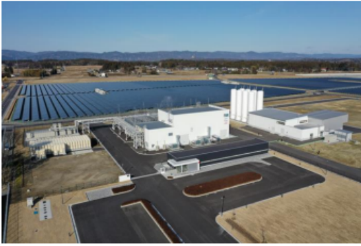
福島水素エネルギー研究フィールド/FH2R（出典：NEDO）
