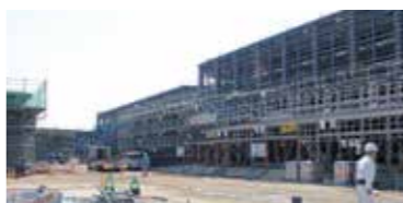
▲建設中の体育館
