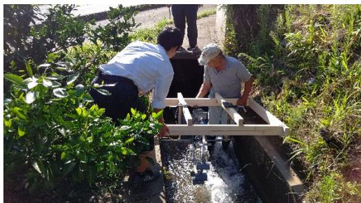
[水路に自作の発電装置を設置している様子]
